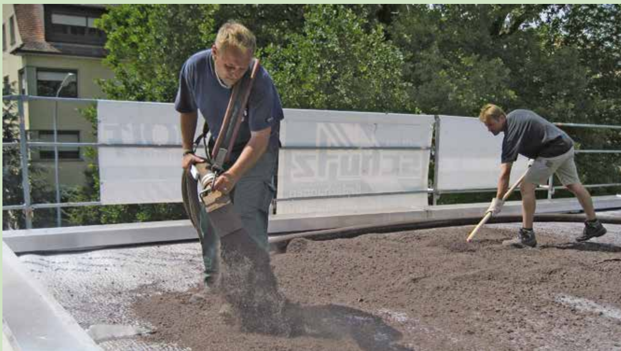
Субстрат наносится пневматическим способом и разравнивается перед высадкой растений
