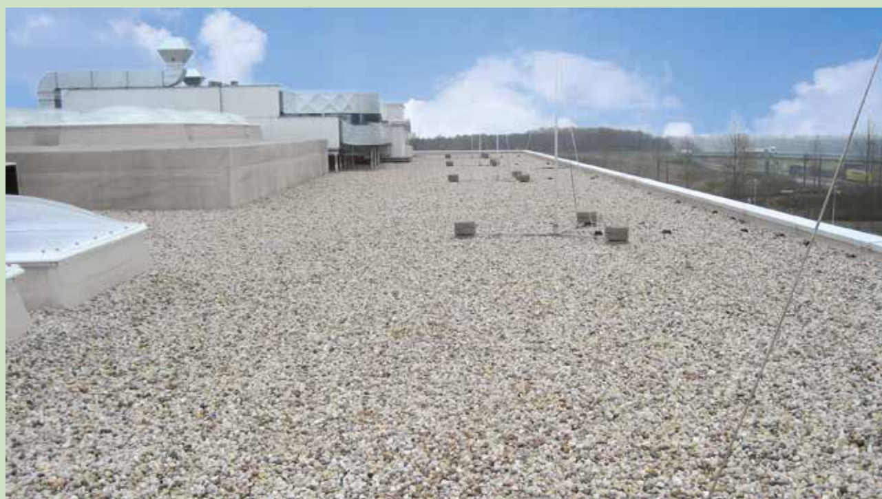
Балластная кровля торгового центра с DELTA®-TERRAXX
