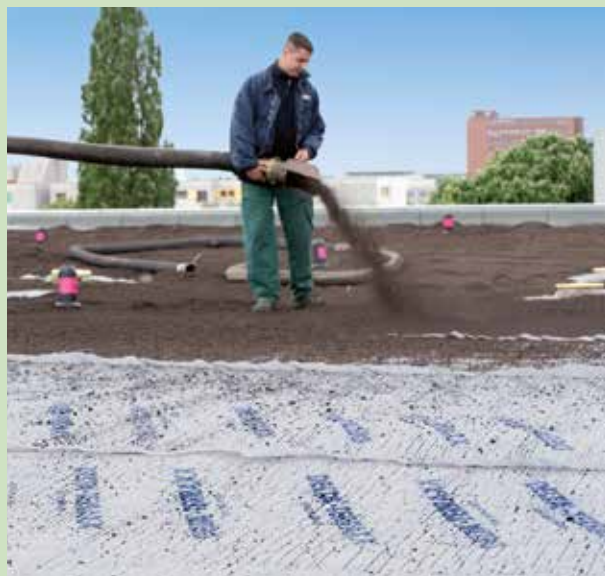
DELTA®-TERRAXX при реконструкции плоской кровли спортивной школы в Кёльне, 2011 г.
